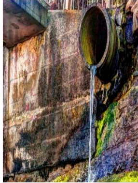
شكل (4.11) تصريف المخلفات السائلة إلى شبكة الصرف
